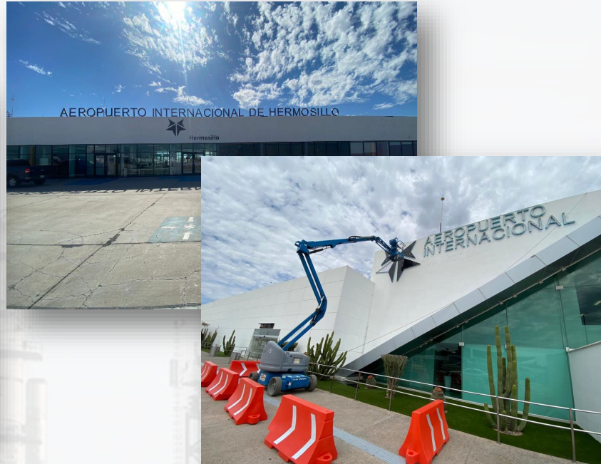
GRUPO AEROPUERTUARIO DEL PACIFICO AEROPUERTO INTERNACION DE HERMOSILLO
